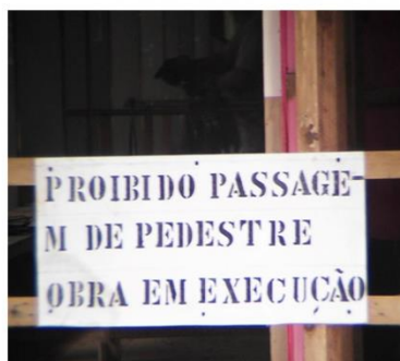
Figura 1: Placa indicando a presença de obras no IEL
