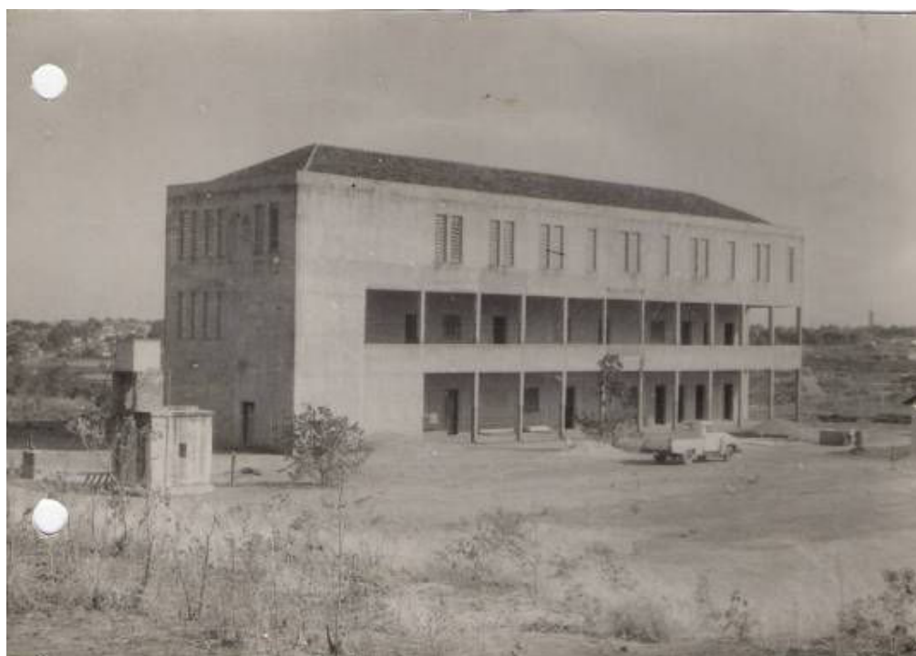
Figura 03 - Vista frontal do prédio do Ginásio Profissional Cristo Rei, conhecido na cidade por Mineirão
