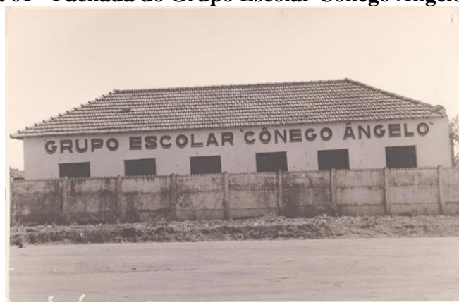
Figura 01 - Fachada do Grupo Escolar Cônego Ângelo (1967)
