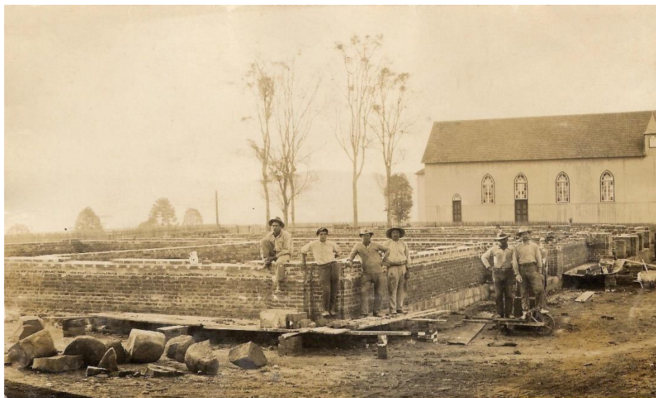
Figura 02 – Construção da Escola Nossa Senhora das Graças. Ao fundo, Igreja São Miguel. Fonte: CEDOC/I – Centro de Documentação e Memória da Unicentro/Irati.
