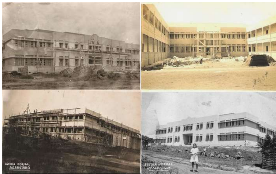
Figura 01 – Etapas da construção do prédio 10 . Fonte: HISTEDBR, 2014.
