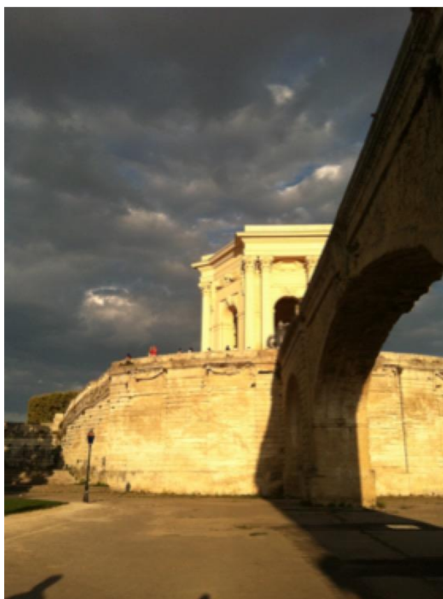
Figure 4 – Montpellier, aqueduc Saint Clément et château d'eau
