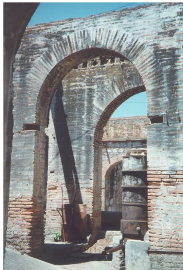
Figura 4. Hacienda y Fábrica en Nayarit (ca. 1840-1910). Arquitectura tipo Hacienda de la Fábrica "Bellavista", Tepic. (ca. 1843) Se aprecia detalle de la caldera de vapor vertical. Foto de Humberto Morales.
