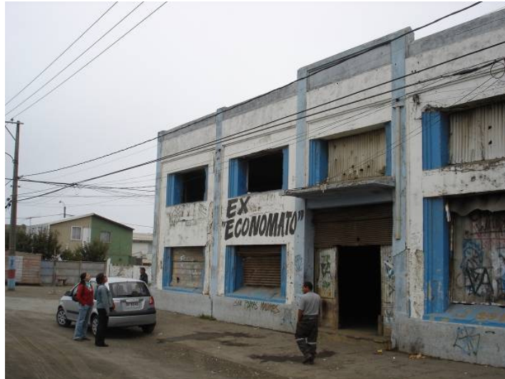
Figura 15. Ex Economato (en uso como locales comerciales), visto desde la línea férrea. Fuente: L. Pérez, 2008.
