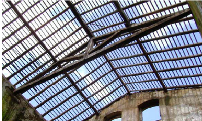
Figura 11. Detalhes da estrutura de madeira da cobertura. Fonte: 19ª SR/IPHAN-PI, 2007.
