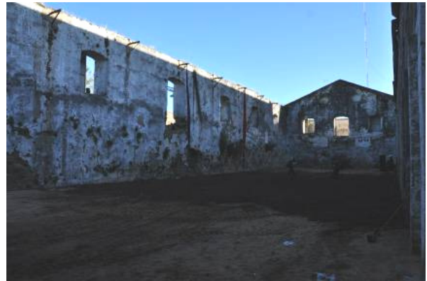
Figura 6. Bodega Harriague sector de doble altura.
