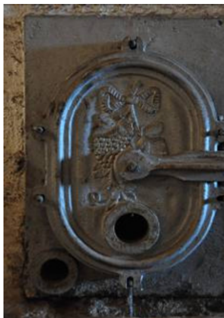
Figura 1. Puerta en hierro fundido de una de las cubas de la Bodega Harriague.
