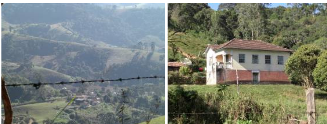
Figura 8. Bairro Carneiros, em Maria da Fé [MG], ao amanhecer. Casa em alvenaria de tijolo, característica da região. Fotos: Eneida Cruz, 2008.
