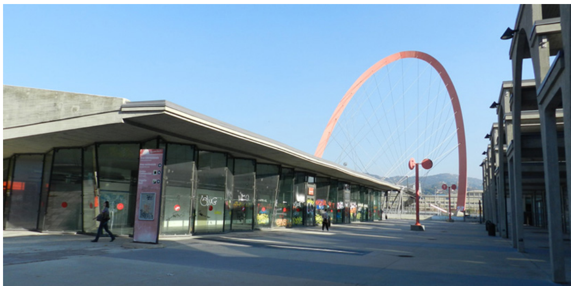
Figura 12. Torino, Mercati Generali, 1932-37. Particolare dei padiglioni oggetto dell'intervento di rifunzionalizzazione. Foto: Mattone.
