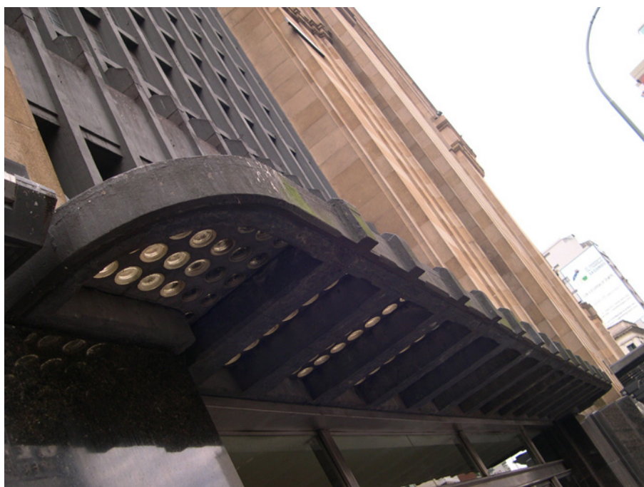
Figura 4. Buenos Aires, Mercado de Abasto Proveedor, 1929-34. Pensilina in calcestruzzo armato e vetrocemento all'ingresso. Foto: Mattone.
