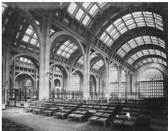
Figura 2. Buenos Aires, Mercado de Abasto Proveedor, 1929-34. Interno. Foto storica.
