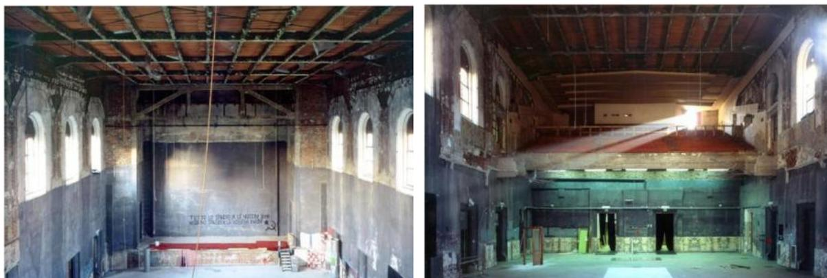
**Figura 4.** Alcune immagini degli interni dopo il lungo periodo di abbandono: lo spazio della sala è stato profondamente compromesso con la demolizione della galleria. Foto: Biamino, 2004.
