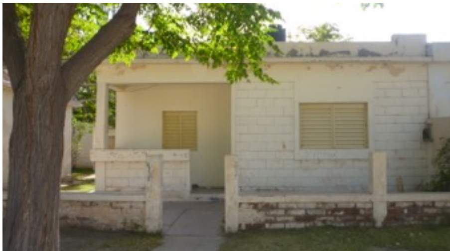
Figura 6. Casa en fábrica Capdeville (G. Moretti, 2010).
