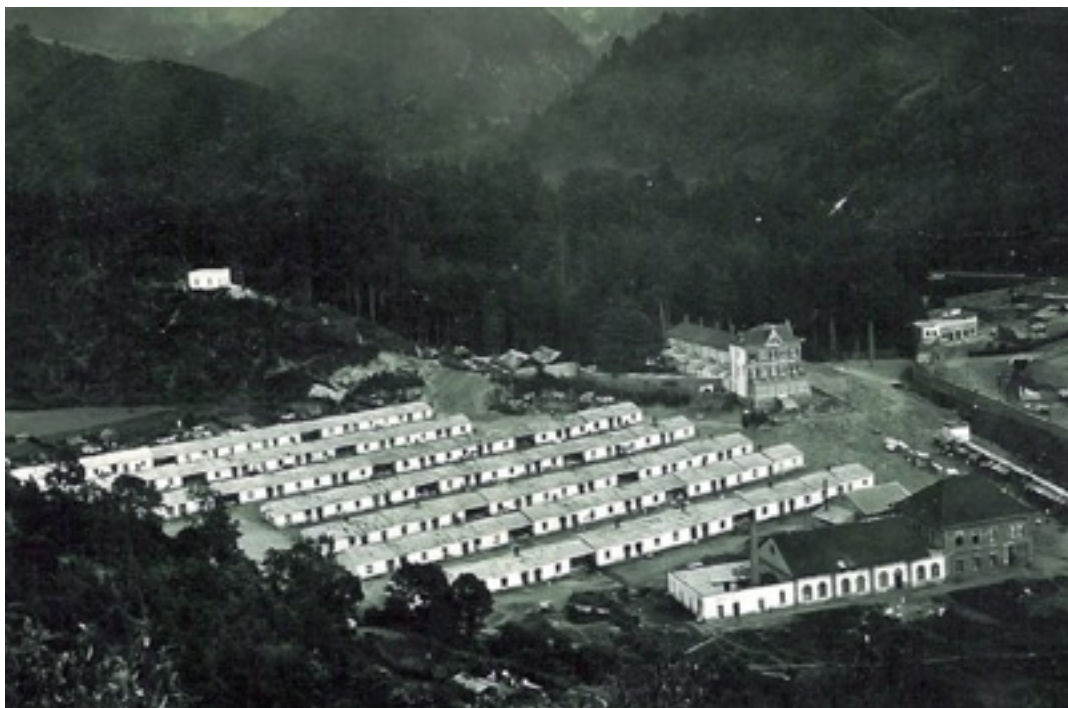
Figura 4. Vista de los cuartos donde se instalaron a los trabajadores. Fuente: AHPSR, sección impresas, serie construcciones exteriores.
