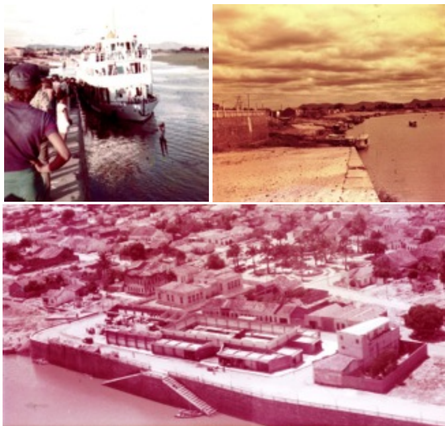
Figura 4. No alto e à esquerda: Cais de Remanso. No alto e à direita: Porto para grandes embarcações vapores na cidade de Remanso. Na parte de baixo: Porto Fluvial década de 70. Fonte: Remanso, Julho 2013. Imagens fotográficas cedidas por Torvinho Regis, Ariosto Pereira e Lucia Libório.
