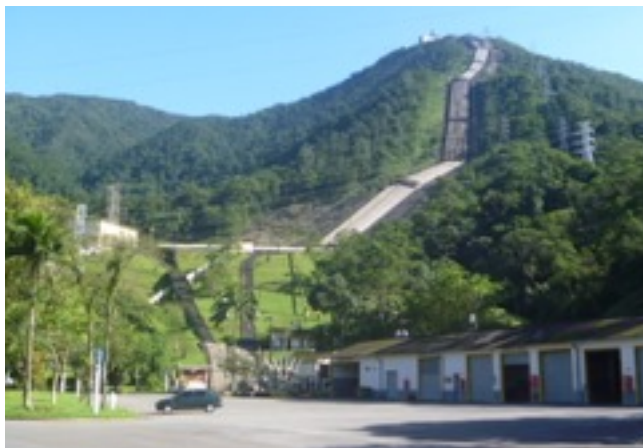
Figura 2. Vista da chegada da tubulação adutora na usina Henry Borden. Foto do Autor, em 30 jul. 2014.
