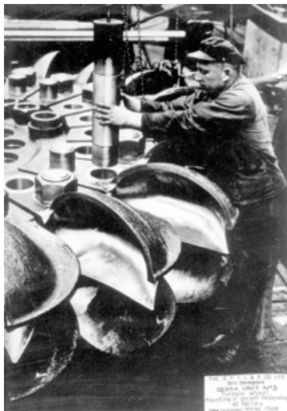
Figura 1. Acima: vista interna da Usina de Itupararanga durante pintura geral e das unidades geradoras, 1972. Acervo EMAE — Empresa Metropolitana de Águas e Energia. À esquerda: montagem da roda da turbina, da unidade geradora nº 3 da Usina Henri Borden. Cubatão/SP, 1935. Acervo Fundação Energia e Saneamento. A complementaridade dos acervos documentais da Fundação Energia e Saneamento e da EMAE está demonstrada nas imagens. Enquanto na Fundação encontram-se principalmente documentos da construção das primeiras usinas, no depósito da EMAE localizado na Usina da Traição, foram encontradas fotos relacionadas à manutenção e à operação das usinas em períodos mais recentes.
