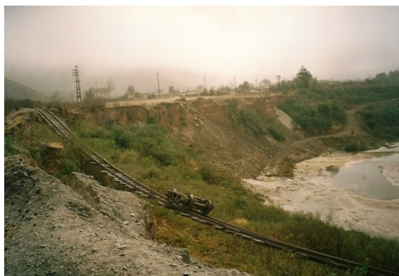
Figura 23. La vía abandonada y socavada por el río antes de llegar a Volcán.
