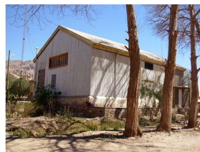
Figura 21. Depósito de cargas en estación Maimará.
