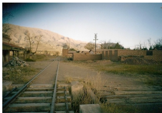
Figura 24. Ocupación ilegal en el cuadro de estación en Huacalera. Nótese hacia el lado derecho de la vía las obras en construcción de viviendas particulares.
