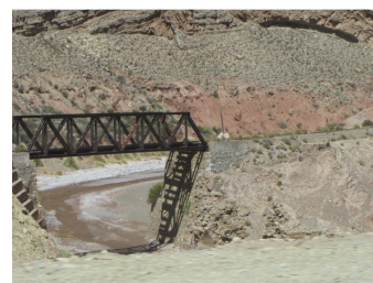
Figura 5. Puente reticulado de un tramo cerca de Esquinas Blancas.
