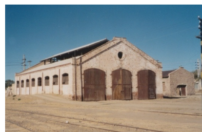
Figura 19. Depósito de locomotoras en estación La Quiaca.
