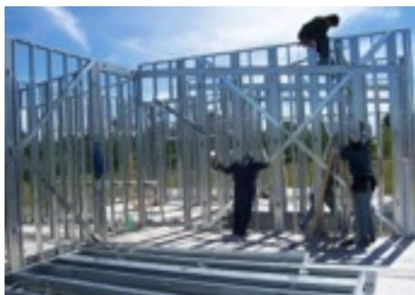
**Figura 2.** Estructuración típica de una construcción utilizando marcos de acero formado en frío de pared delgada (agroads.com)
