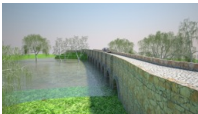
Figura 1. El puente de San Ignacio comunicaba la ciudad de Aguascalientes con la antigua Fábrica de San Ignacio. Reconstrucción digital: Renato Daniel Guerra Ibarra/Alejandro Acosta Collazo, febrero 2013.
