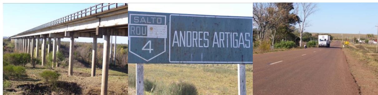
Figura 3. Puente sobre el Río Arapey Grande, cartelería y una pavimentada Ruta Nº4.
