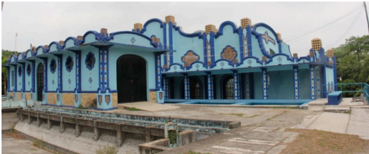
Figura 3. En primer término el pabellón del laboratorio, detrás la sala de máquinas de la antigua Planta "Hidros". Foto: Martín M. Checa-Artasu, mayo 2013.
