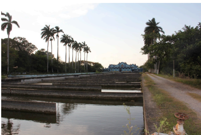
Figura 4. Vista de los tanques de sedimentación con la planta de la "Hidros" al fondo. Foto: Martín M. Checa-Artasu, junio 2013.
