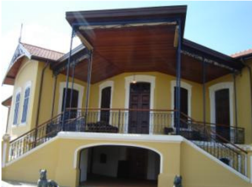
Figura 5. Alpendre da sede da Fazenda São Vicente com a entrada do porão. Foto: Amoroso (2007)
