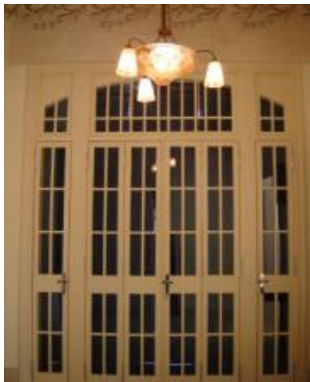
Figura 8. Janelas possuía caixilhos de pinho de Riga com vidros importados. Foto: Amoroso M.R. (2007).
