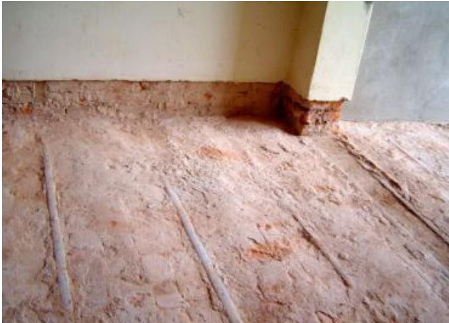
Figura 10. Laje em abobadilha. Observar os trilhos e os tijolos nos entre meios. Fonte: Amoroso M.R. (2005).
