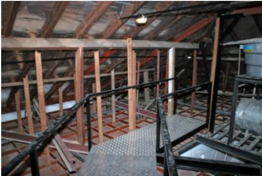
Figura 9. Detalhe do sótão da Fazenda São Vicente, verificar a passarela criada no restauro para manutenção. Foto: Amoroso M.R. (2006).
