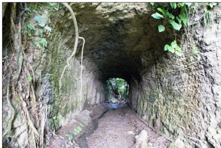
Figura 2. Antiguo túnel de la red ferroviaria Cobos-Furbero (tomado y modificado de internet).
