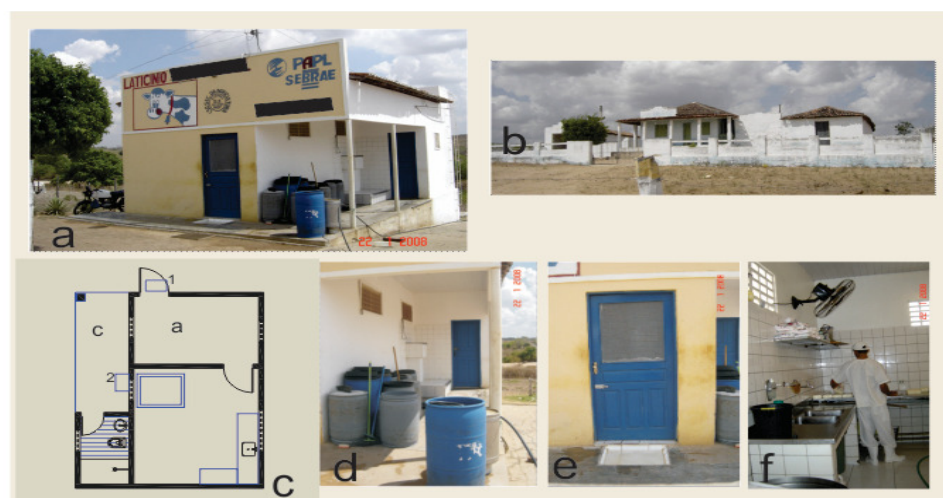
Figura 7. Laticínio 1. a) Vista externa do Laticínio 1; b) Casa sede da fazenda; c) Planta baixa do Laticínio 1; d) Vista do terraço de recepção do leite com porta do banheiro ao fundo; e) Acesso a parte interna do Laticínio com instalação de pedilúvio; f) Parte interna do espaço de fabricação.
