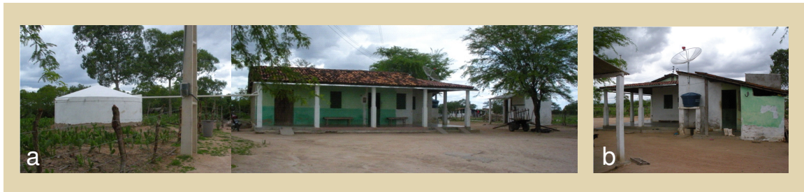
Figura 3. Vista externa da propriedade da Fabriqueta 1. a) Cisterna de placas, no lado esquerdo da casa e do lado direito da casa, a queijaria; b) Vista lateral da casa com a porta da cozinha.
