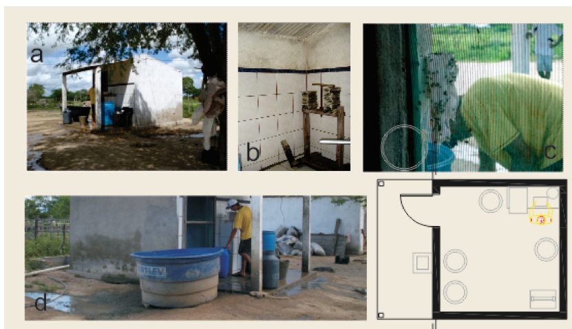
Figura 5. Fabriqueta 1. a) Vista externa da queijaria; b) Parte das paredes internas são revestidas com material cerâmico; c) Porta telada para evitar moscas e outros insetos; d) Lavagem dos tambores plásticos e do piso após recebimento do leite, o escoamento da água é feito no próprio terreno.
