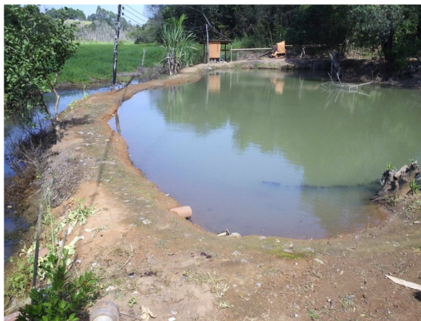
b – Reservatório com pequenas dimensões e dique paralelo ao curso de água.
