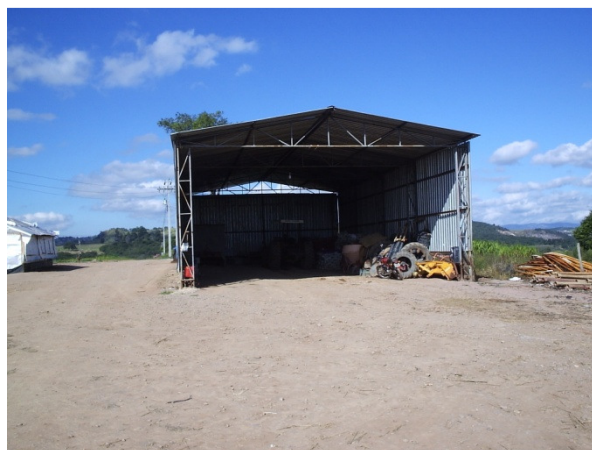
a – Galpão e pátio para estacionamento.
