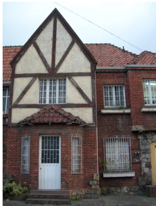
Figura 2. Casa destinada a oficinas en el barrio de Teusaquillo, Bogotá. 2015. Fotografía del autor.
