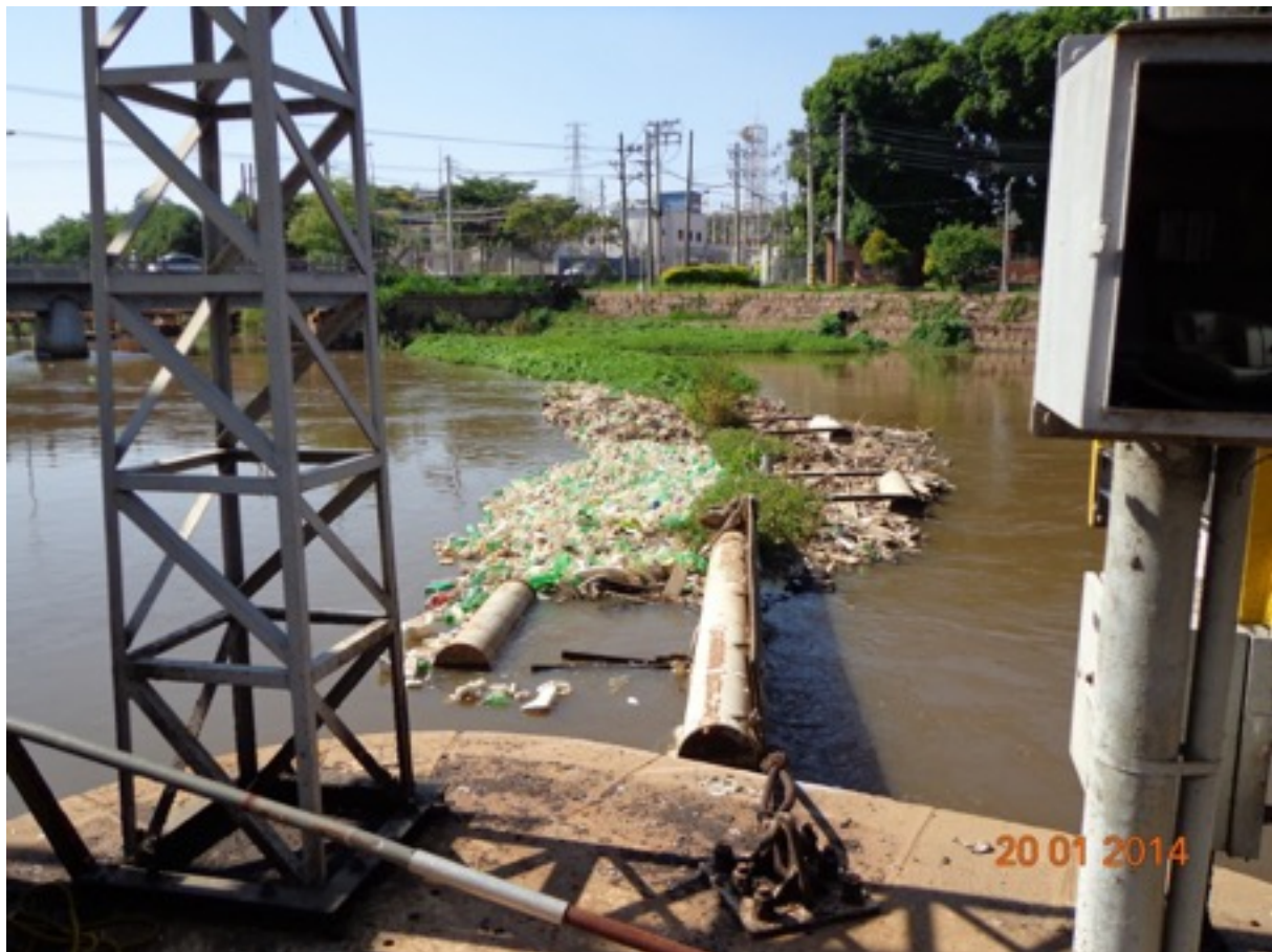
Figura 3. Barreira de resíduos sólidos próxima à entrada do canal de adução da Usina Porto Goés com acúmulo de material plástico como garrafas PET. Foto: Giorgia Limnios, 20.01.2014.
