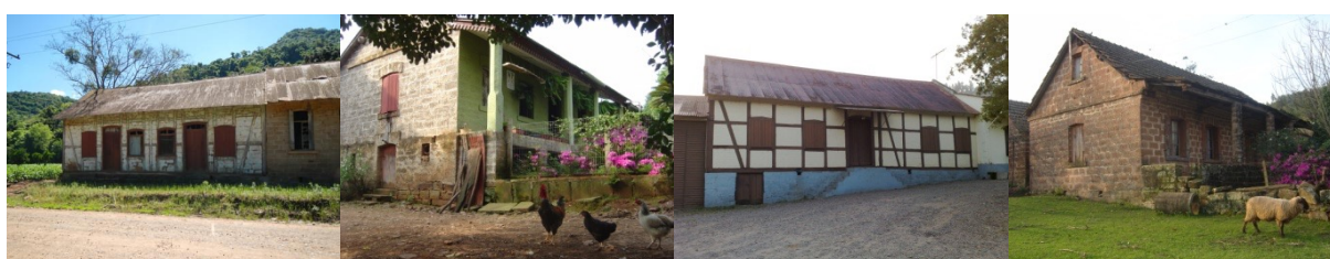
Figura 9. Ejemplares destacados de arquitectura “enxaimel” y métodos tradicionales de construcción presentes en el municipio de Agudo: Salón y casa de comercio Müller – actualmente desactivada, residencia en Linha Boemia , Casa Comercial Müller ( Picada do Rio ) y residencia en Linha das Flores . Fotos del autor, 2013, 2009, 2010 y 2009 respectivamente.
