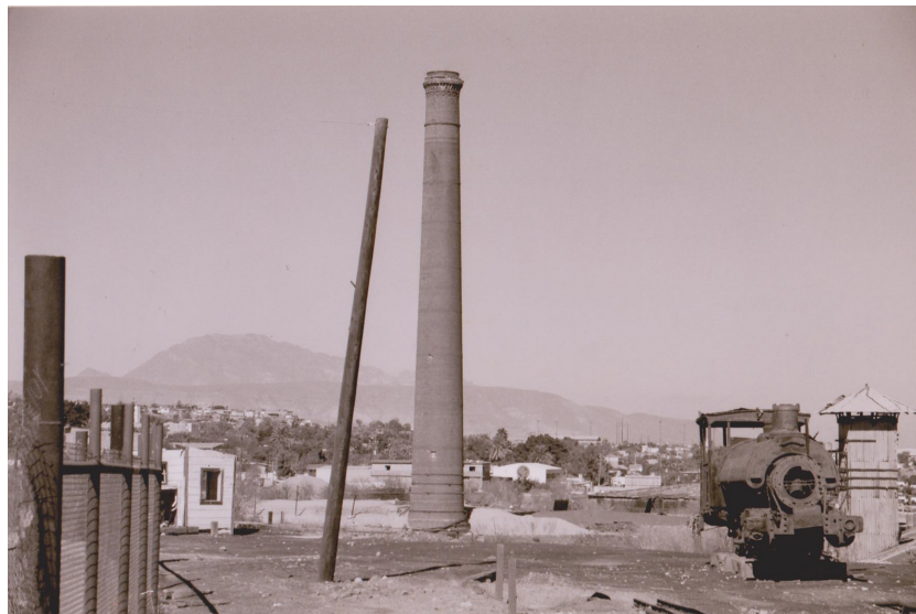
Figura 9. El ferrocarril conectaba los 3 grupos mineros de nombre apocalíptico: La Providencia, El Purgatorio y La Soledad que distaban del puerto de Santa Rosalía a 5,7 y 10 Km. La vía fue tendida en camino natural atravesando el centro del pueblo y por las orillas entre secas mesetas y lomeríos hasta alcanzar los tendidos de los grupos mineros (Romero Manuel, 1991. El Boleo: un pueblo que se negó a morir: 1885-1954 . Hermosillo, Sonora. Editorial Unfsono). La articulación entre los poblados y el puerto hacían a la company town un mecanismo urbano de eficiencia industrial que funcionaba para extraer la mayor cantidad de cobre posible.
