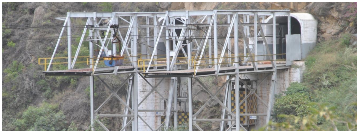
Figura 5. Entrada y Salida a los túneles con las góndolas transportadoras Fuente: Armando Muñoz Luque.
