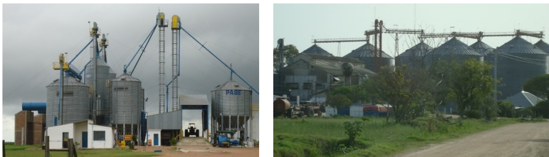
Figura 10. Secador y Silos en San Fernando y La Planta en Arrozal 33. Fuente: S. Martínez.
