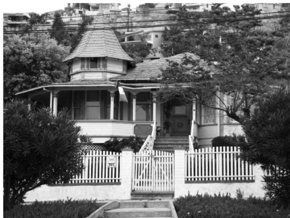
Figura 12. Residencia estilo victoriano construida en Ensenada en 1893 por Francisco Andonaegui y que ocupan actualmente sus descendientes. La residencia forma parte de los catálogos que publicaban las compañías constructoras del este de los Estados Unidos. Para construir la casa de Andonaegui las piezas de madera llegaron por barco, después de bajar hasta el Cabo de Hornos y subir después por el Océano Pacífico hasta el puerto de Ensenada (una travesía increíble que muestra la importancia de esa época para poblar esta región). Foto de Javier Hernández. Fuente: Expresiones arquitectónicas compartidas en la frontera de Baja California de David Piñera y Alma Bejarano
