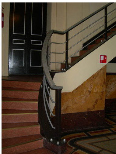
Figura 14. La scala del ballatoio nella sala macchine (foto: E. Romeo).
