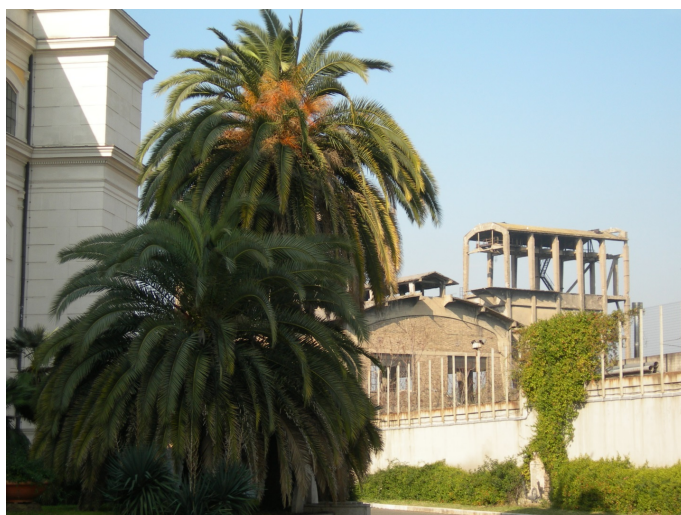
Figura 9. Veduta del cortile d'ingresso; sullo sfondo gli edifici industriali annessi alla Centrale Montemartini (foto: E. Romeo).
