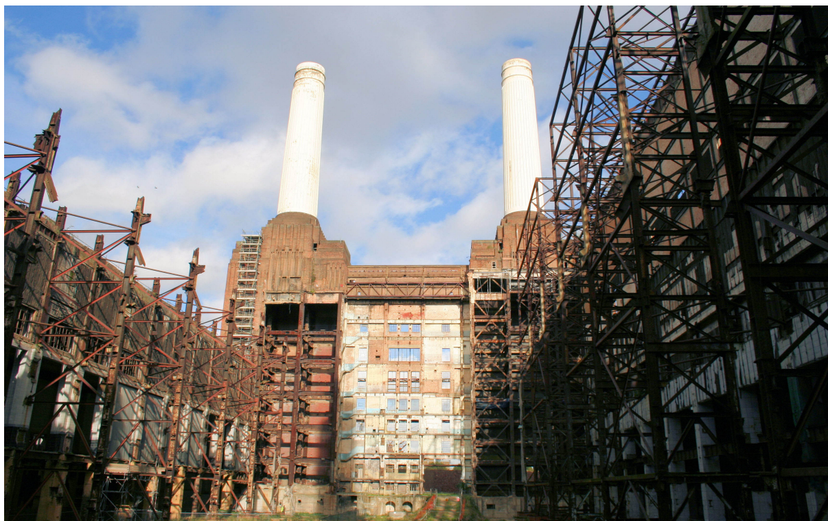
Figura 5. Lo spazio vuoto all'interno della centrale.
