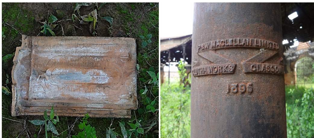
Figura 2. (a) Telhas francesas e (b) estrutura metálica escocesa. Fonte: Ronaldo André Rodrigues, 2013.
