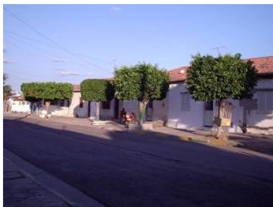
Figura 24. Residências N5, com 2 ou 3 dormitórios. Fonte: acervo próprio.
