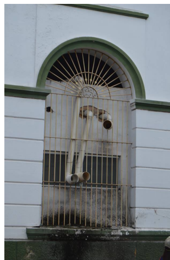
Figura 7. Janela lateral. Instalação pluvial. Fonte: Douglas Oliveira (2017).
