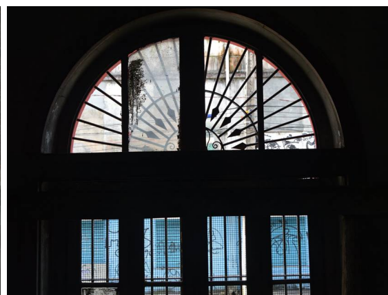
Figura 9. Preservação da Janela original da Fábrica Perseverança. Fonte: Douglas Oliveira (2017).
