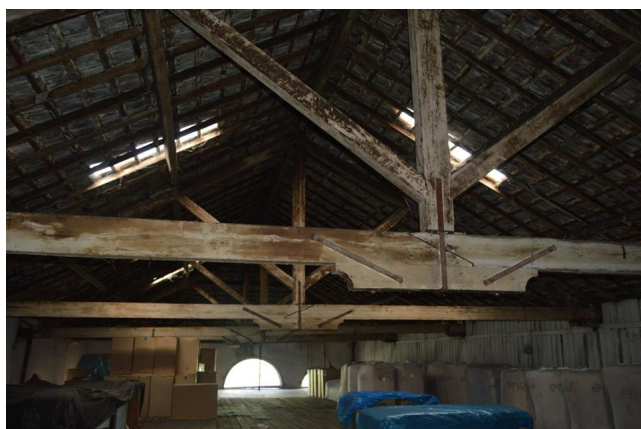
Figura 8. Tesouras de madeira, estrutura de telhado da Perseverança. Fonte: Douglas Oliveira (2017).
