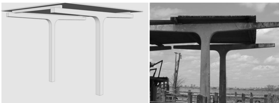
Figura 17. Sistema pilar central e viga única presentes em cocheiras no Parque de Exposições de Animais de Campina Grande. Fonte: Afonso & Pereira, 2019.
