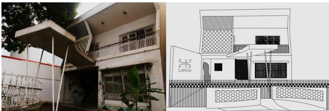
Figura 14. Residência Gabbay (Década de 1950), de Laurindo Amorim. À esquerda, foto da fachada. À direita, redesenho da fachada. Fonte: Celma Chaves, 2018 (foto); Acervo Lahca/UFPA, 2014 (redesenho. Autoria: Larissa Garcia e Rebeca Dias)
