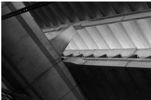
Figura 10. Detalhe tectônico do lanternim utilizado na cobertura da estrutura. Fonte: Alcilia Afonso (2018).
