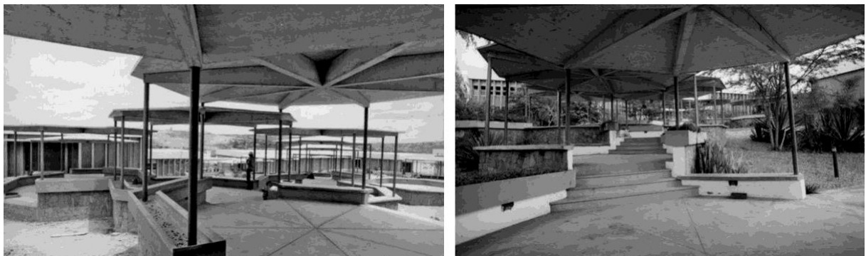
Figura 8. Estrutura pré-fabricada da escadaria coberta. Fonte: CSA Arquitetura (2018).
