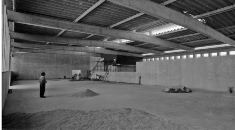
Figura 9. Estrutura em viga única do galpão de couro (esquerda) e detalhe de encaixe da cobertura (direita). Fonte: CSA Arquitetura (2018).
