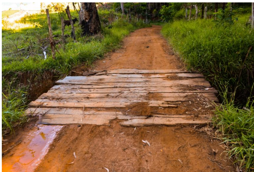
Figura 5. Pontilhão de madeira localizada próximo à comunidade da Jaguará, na Serra da Onça. Fonte: Acervo dos autores.
