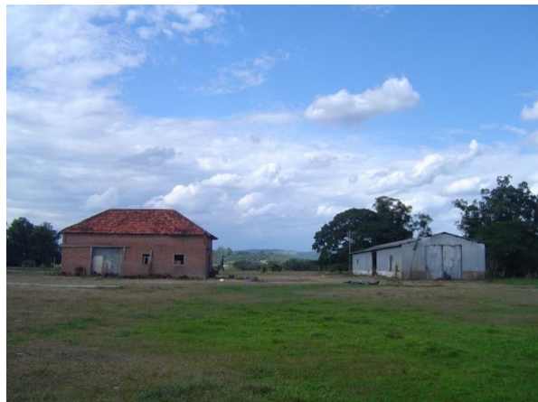
Figuras 16. Edificação depósito em tijolos à vista e galpão metálico. Foto: Rosilene Possamai / Acervo EPAHC.
