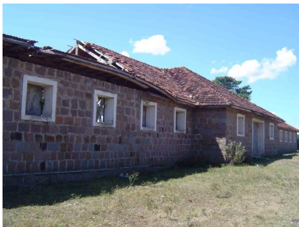
Figuras 12. Edificação principal em pedras graníticas. Foto: Rosilene Possamai /Acervo EPAHC.
