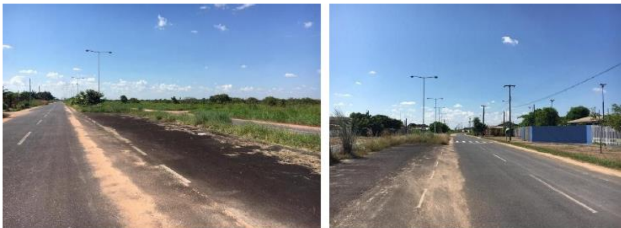
Figuras 3a e 3b. Imagens da Avenida Renato Russo, em Cantá [RR] 2020. Fotos: Os Autores.
