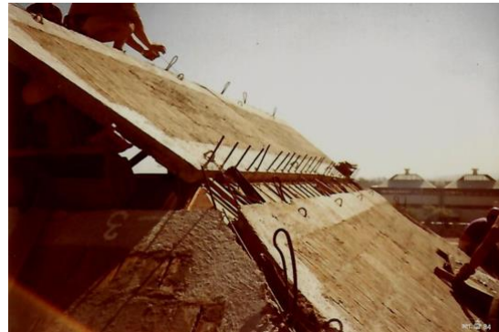
Figura 12. Estrutura de madeira para receber as placas de cerâmica armada na montagem da cúpula e processo de solidarização das placas. Fonte: Arquivo FAM / PROPARG e Marques, 1984.
