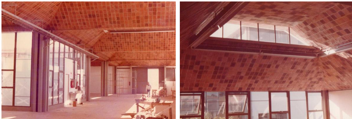
Figura 13. Imagens internas dos módulos com cerâmica aparente nas cúpulas e zenitais. Fonte: Arquivo FAM / PROPARG.
