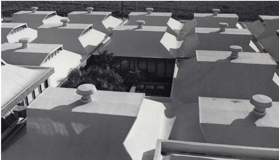
Figura 14. Visão geral da cobertura e pátios de ventilação e iluminação natural. Fonte: Arquivo FAM / PROPAR
