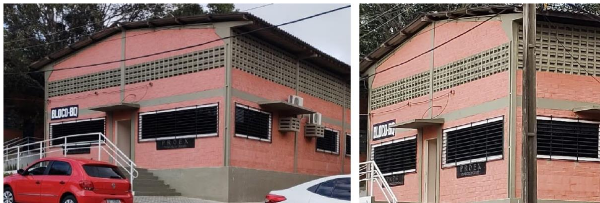
Figura 12. Aplicação de vidro fumê e gradis nas esquadrias em um dos blocos (Bloco BQ) do setor B do campus. Fonte: Pereira, 2022.
