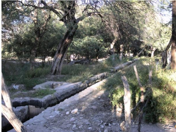
Figura 2. Sistema de acequias para riego. Foto: S. Rossi, 2009.
