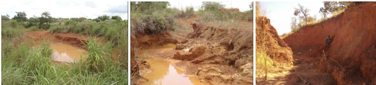
Figura 10. Processo erosivo ao longo da faixa de domínio (margem norte) da DF-250. Fonte: DER-DF, 2018.
