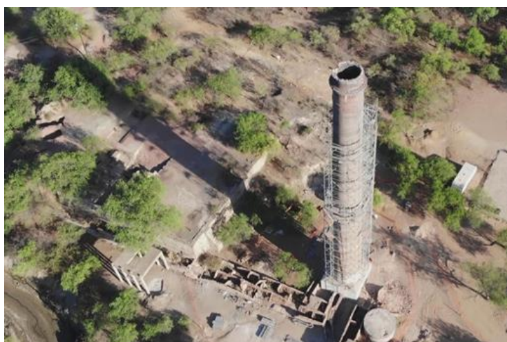
Figura 31. Vista aérea de la chimenea industrial de El Triunfo. Fuente: Fotografía aérea B.V. Mantenimiento a la Chimenea “La Ramona” El Triunfo Baja California Sur, 2019.
