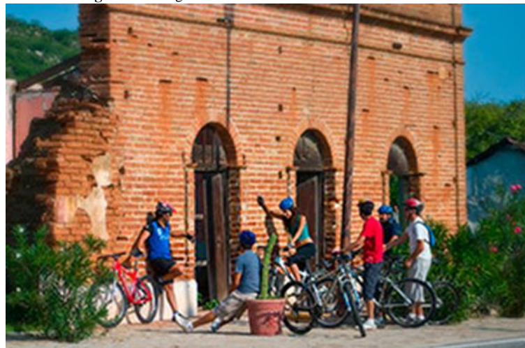
Figura 34. Fotografía de edificio industrial en ruinas. Fuente: Desconocida.
